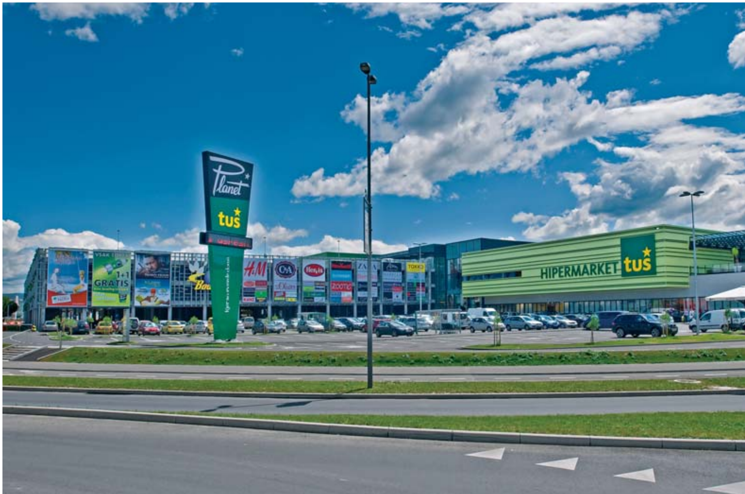
V Tuš centru Koper so vgrajeni Hidriini distributivni elementi, enote za regulacijo zraka ter požarne in dimne lopute
